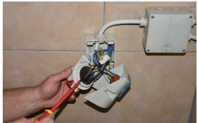
Anschließen einer 400-Volt-Steckdose.
