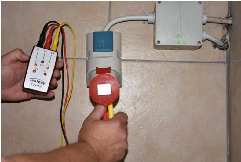
Bei dieser Steckdose ist L2 nicht angeschlossen. Das ist nachzuholen.
